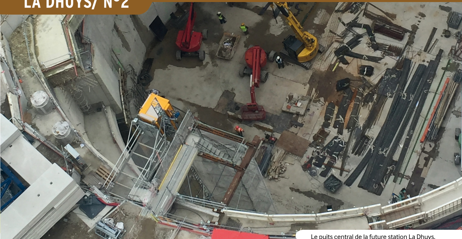
Le puits central de la future station La Dhuis.
