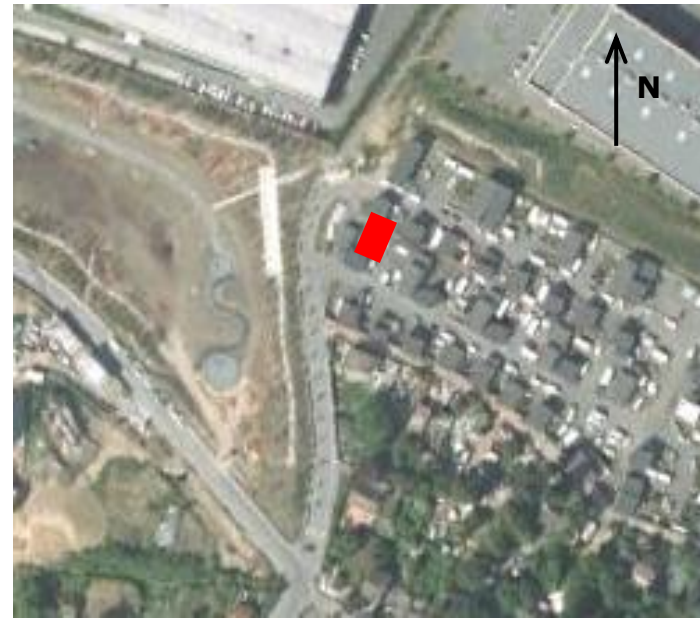
8. Londeau - Poste de redressement
