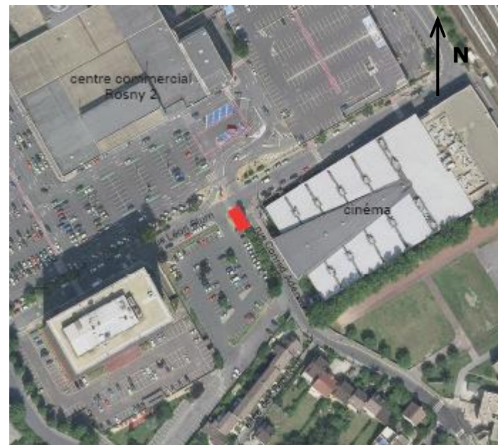
11. Louise Michel - Ventilation/accès pompiers
