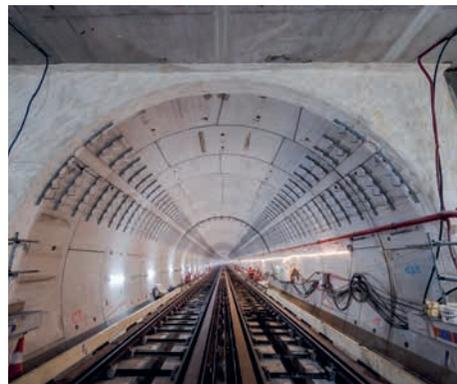
Dans un premier temps, l'équipement des tunnels concerne la pose des voies (traverses, rails) et la pose du « rail traction » permettant l'alimentation électrique des rames. Puis les équipements du système de transport sont installés : la signalisation, les balises de contrôle de vitesse et de position des trains, et d'autres éléments nécessaires à la conduite des trains.
