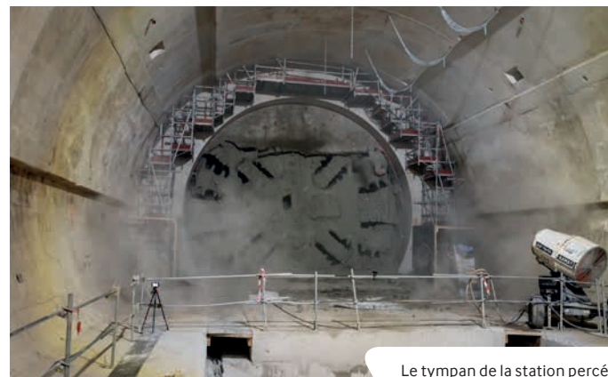
Le tympan de la station percé
