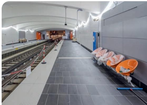
**Les quais de la ligne 11 se finalisent** par l'installation des éclairages, les revêtements de sol et même une partie du mobilier installé comme les sièges, les caméras de sécurité ou les bornes d'appel d'urgence.
